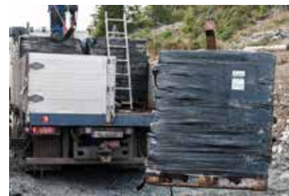
Steg 1: Paller med torvplater løftes på taket med kran.
