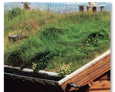
Ved bruk av riktig frøblanding og gjødsling blir torvtaket som gammel setereng etter kort tid (et par år).
