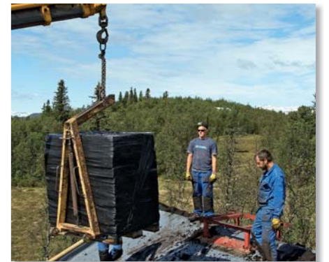
HallingTorv legges raskt og effektivt ved bruk av kranbil
