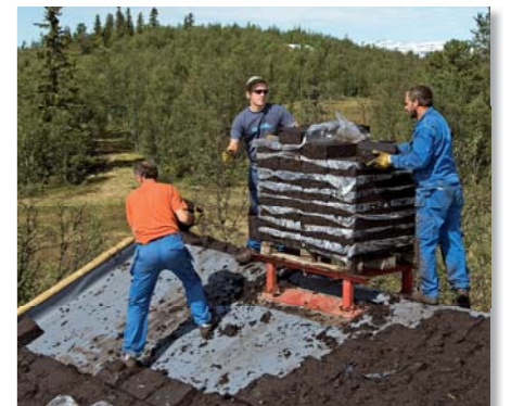
Torvplatene er lette å håndtere, men husk på at underlagsplast o.l. er glatt å gå på!
